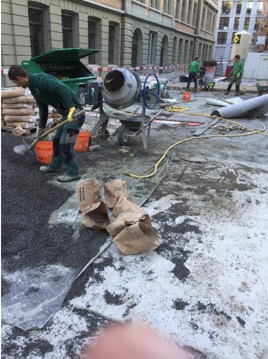
Grobkornbeton mit Trass Compound TCE
