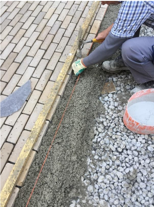
Versetzen der Klinker in Grobkornbeton
